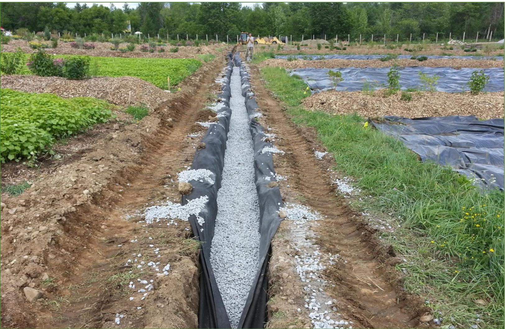
Dans chacune des allées principales, entre les parcelles cultivées, une tranchée d'environ 60 cm a été creusée pour l'installation d'un drain de 10,16 cm de diamètre.
